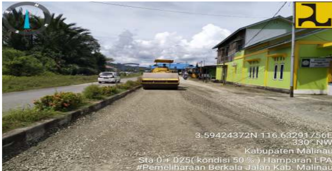
Gambar 3.11 Pemeliharaan Jalan Pelabuhan
