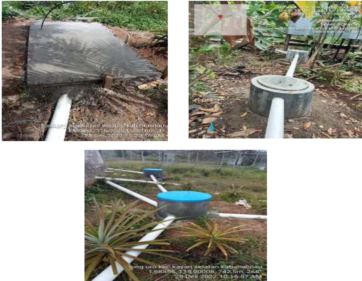
Gambar 3.32 Pembangunan Tangki Septik Sakala Komunal (5-10) Desa Long Uro Kecamatan Kayan Selatan
