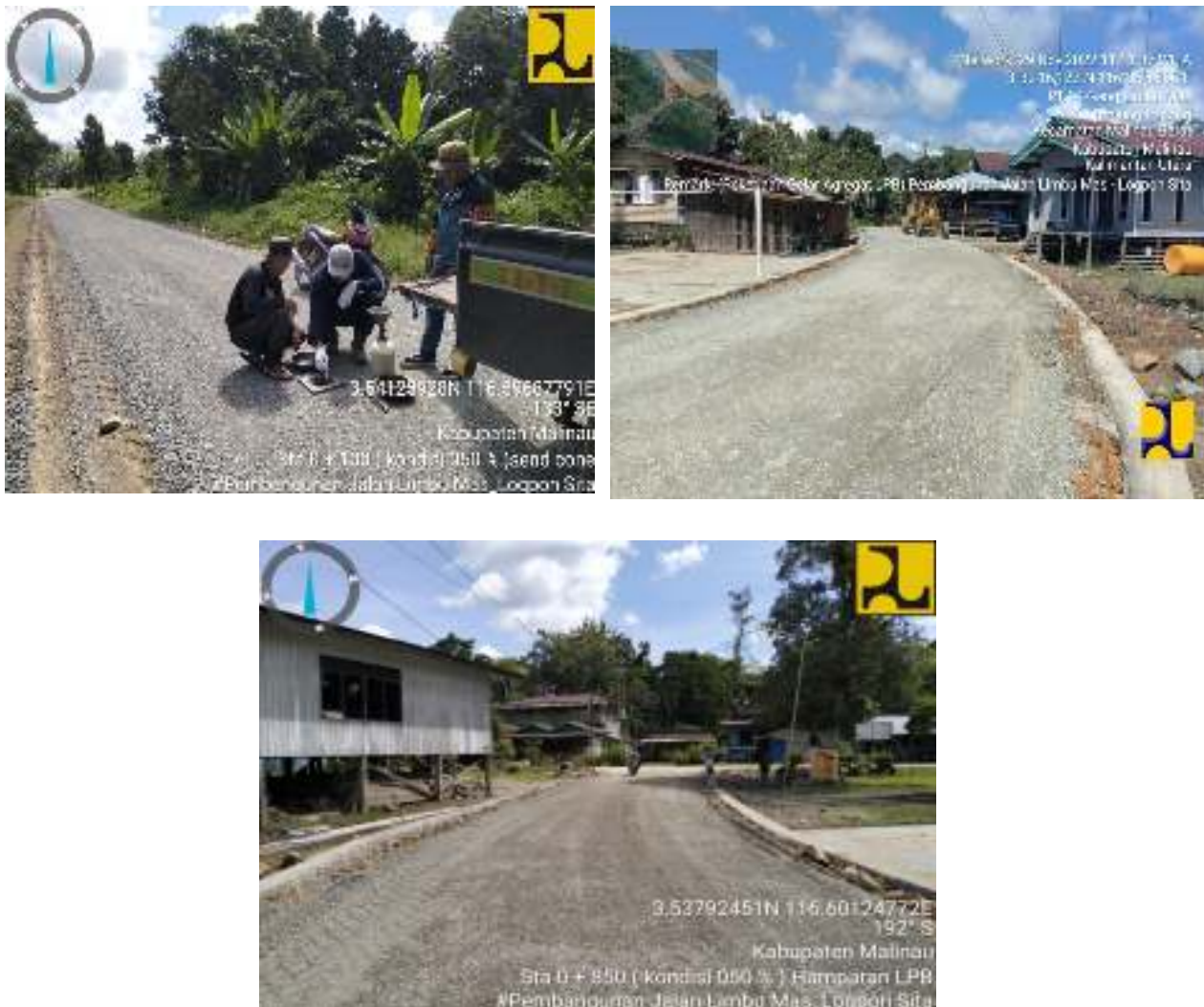
Gambar 3.4 Pembangunan Jalan Limbu Mas-Longpon Sita
