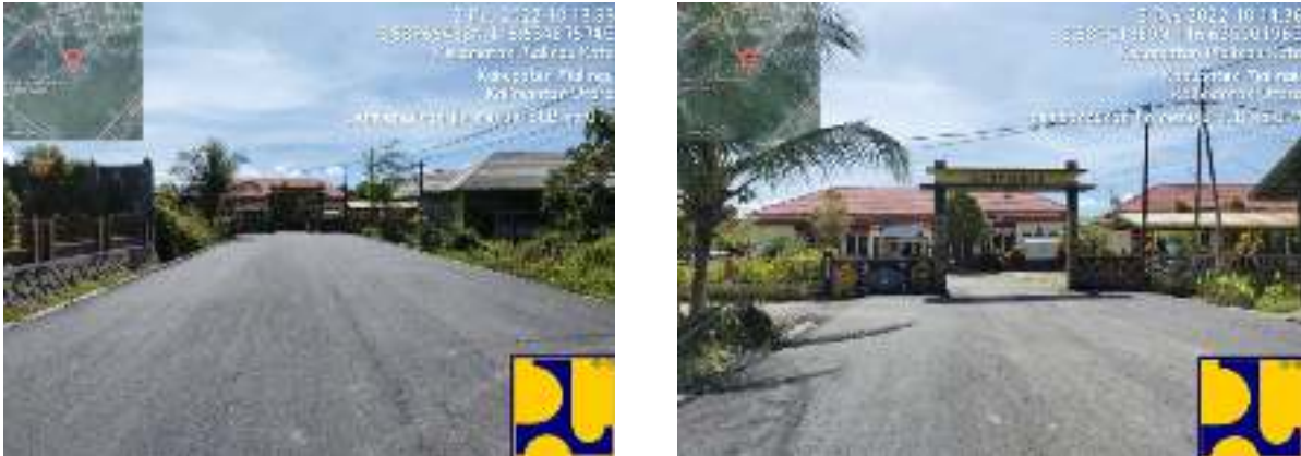
Gambar 3.1 Pembangunan Jalan Menuju SLB No. 071
