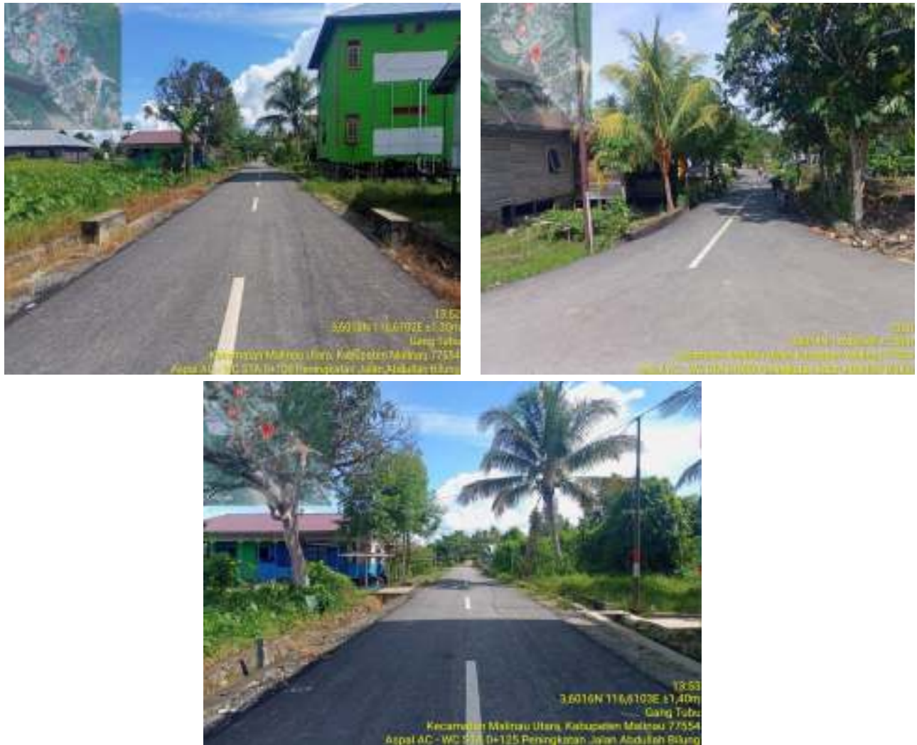
Gambar 3.3 Pembangunan Jalan Abdullah Bilung 2 No. 175
