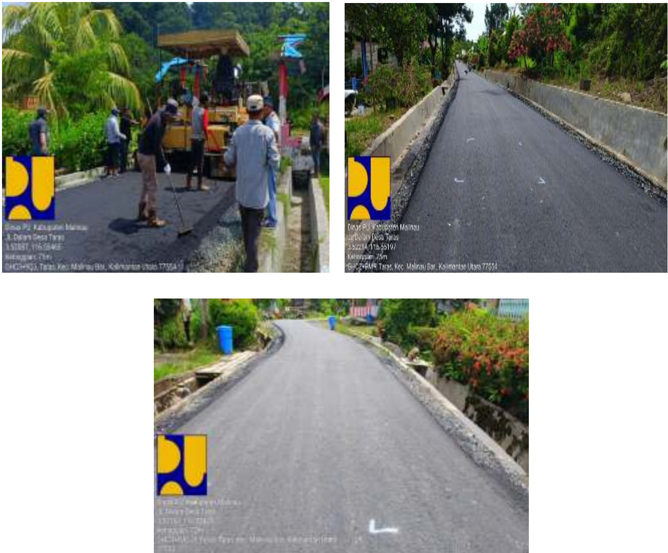
Gambar 3.2 Pembangunan Jalan Desa taras No. 127
