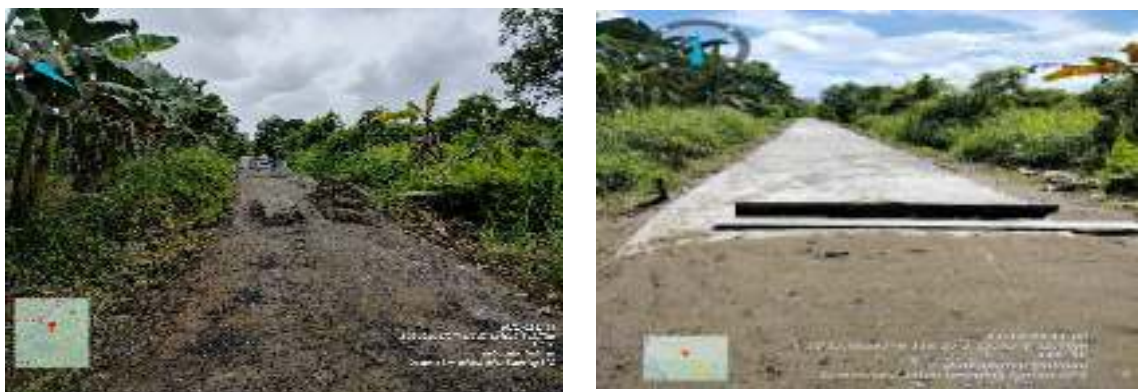
Gambar 3.42 Semenisasi Jalan Gg. Samping Kantor BPS Desa Malinau Hulu
