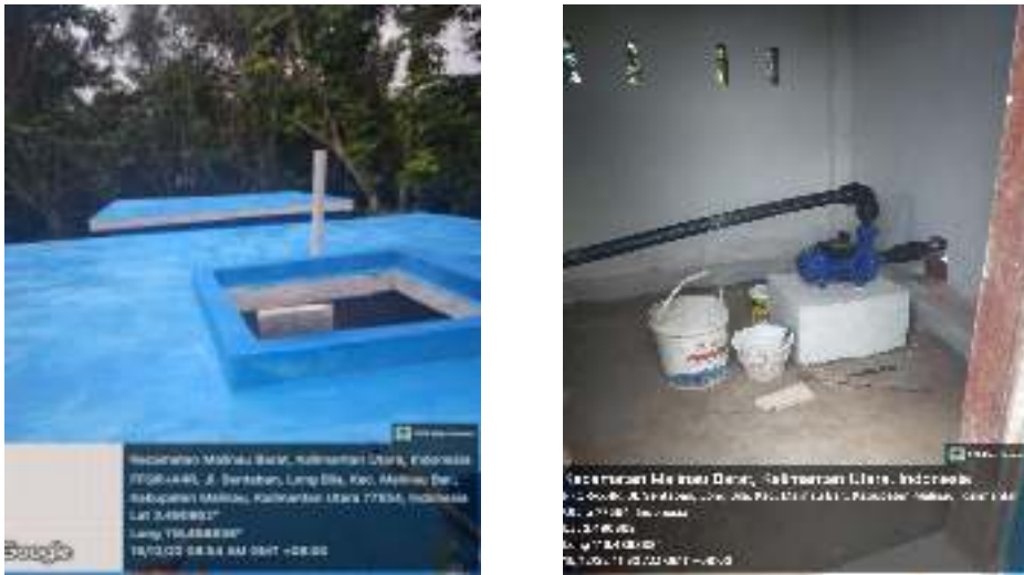
Gambar 3.22 Pembangunan Air Bersih Desa Sentaban
