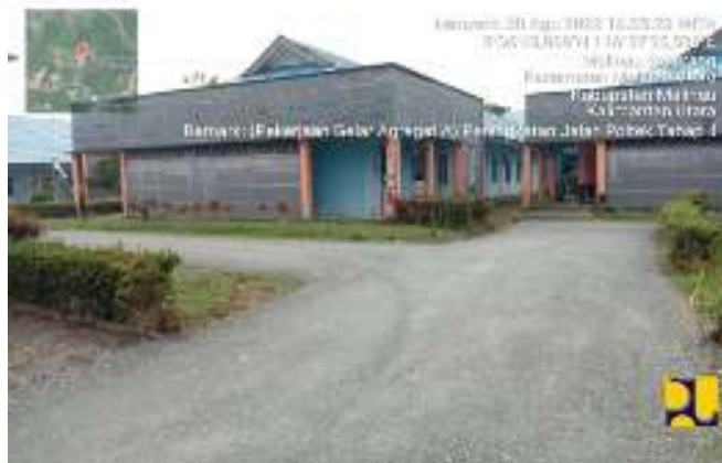
Gambar 3.5 Pembangunan Jalan Poltek Tahap II
