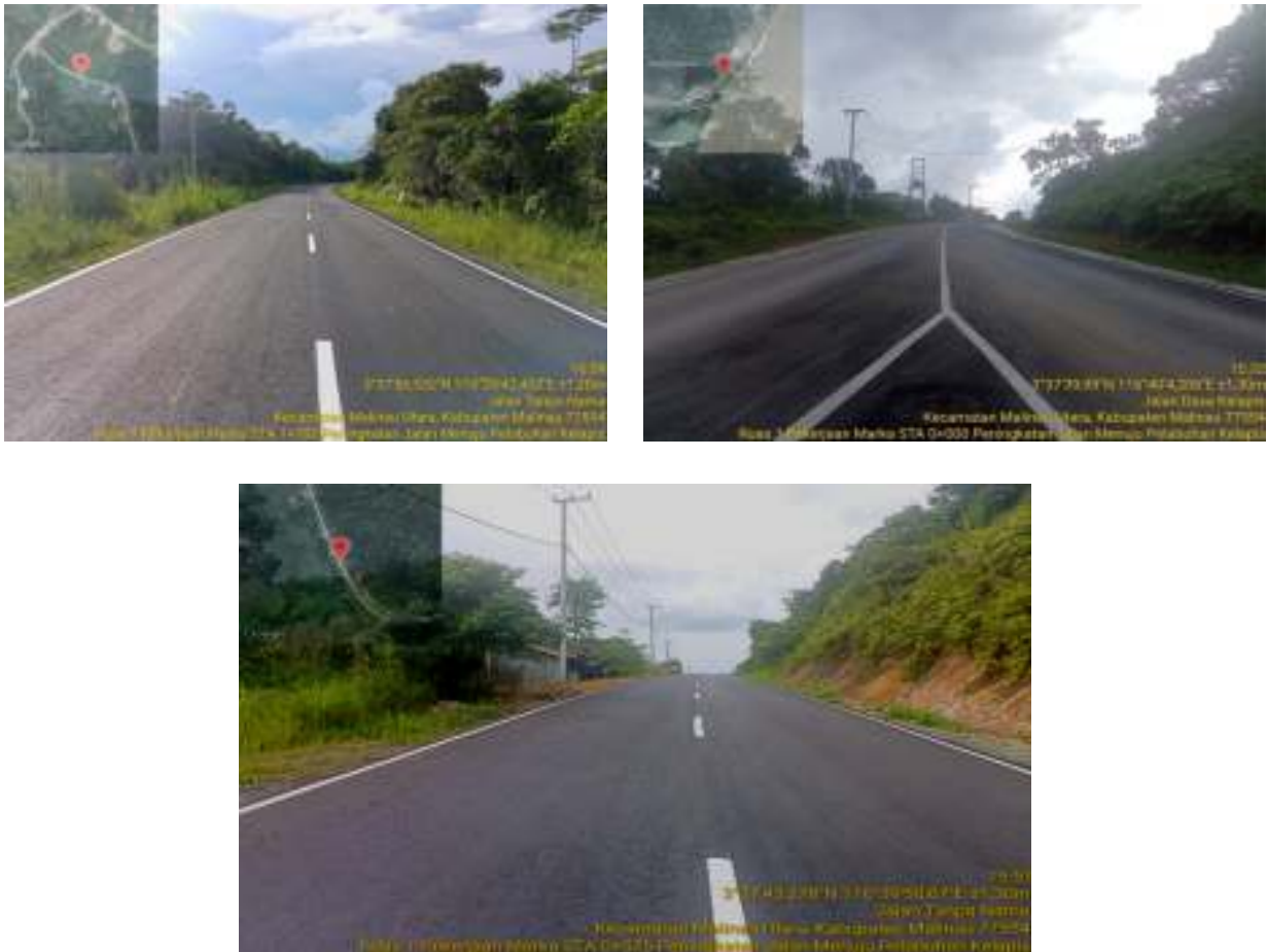
Gambar 3.6 Peningkatan Jalan Menuju Pelabuhan Kelapis
