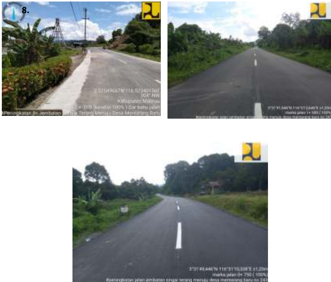
Gambar 3.7 Peningkatan Jalan Jembatan Singai Terang Menuju Desa Mentarang Baru
