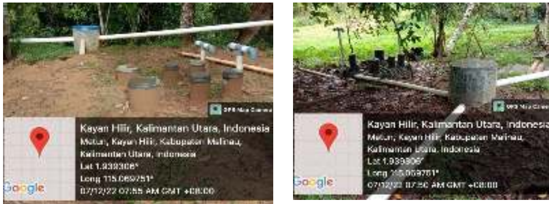
Gambar 3.30 Pembangunan Tangki Septik Skala Komunal (5-10 KK) Desa Metun Kecamatan Kayan Hilir
