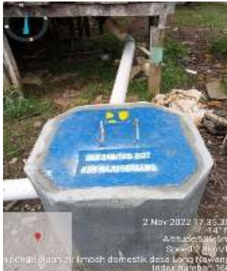
Gambar 3.31 Pembangunan Tangki Septik Skala Komunal (5-10 KK) Desa Long Nawang Kecamatan Kayan Hulu
