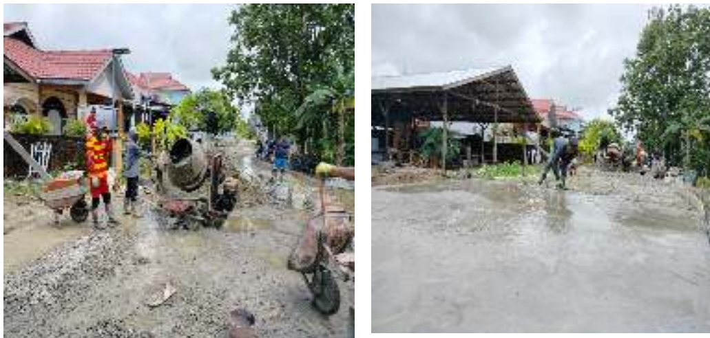
Gambar 3.40 Semenisasi Jalan Gg. Tenguyun RT 10 Desa Malinau Kota
