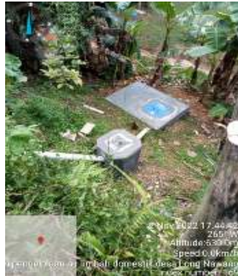
Gambar 3.31 Pembangunan Tangki Septik Skala Komunal (5-10 KK) Desa Long Nawang Kecamatan Kayan Hulu
