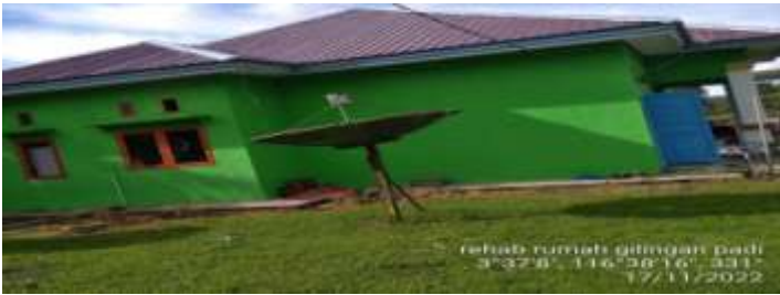
Gambar 3 : Rehab Rumah Gilingan Padi
