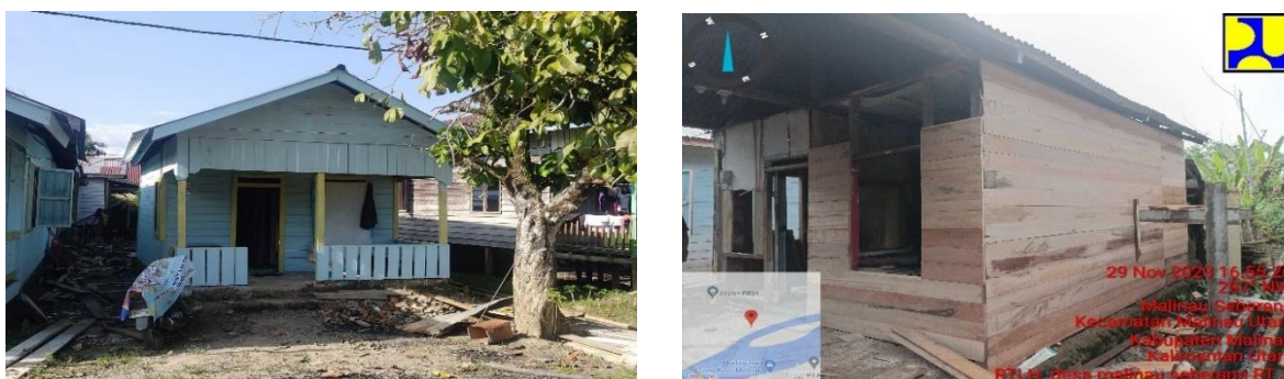
Gambar 3.43 Renovasi Rumah Tidak Layak Huni
