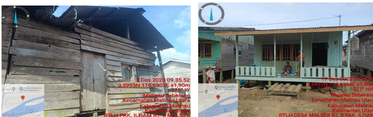
Gambar 3.44 Renovasi Rumah Tidak Layak Huni
