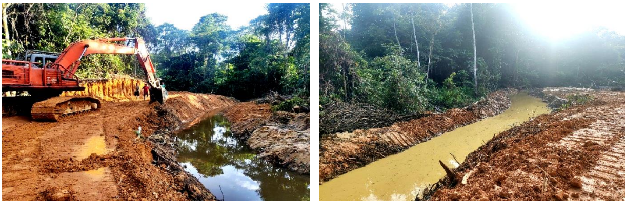
Gambar 3.57 Pembangunan Jaringan Irigasi Kuala Lapang
