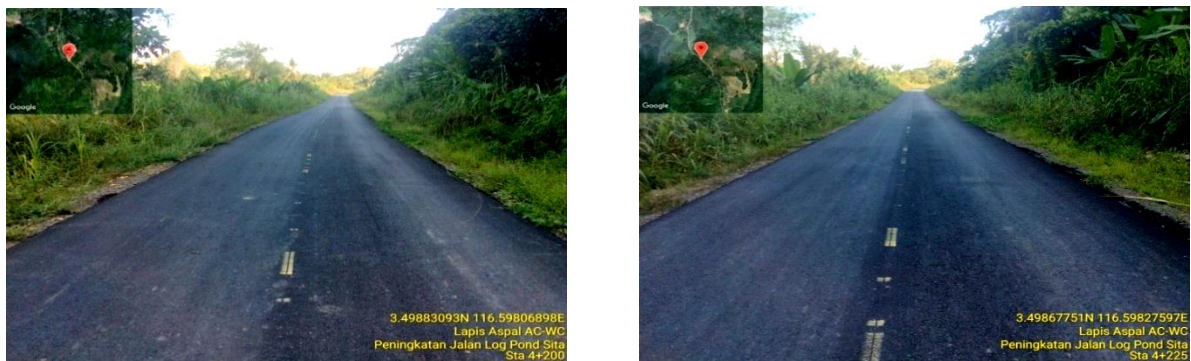
Gambar 3.4 Peningkatan Jalan Eks Inhutani II Logpon Sita
