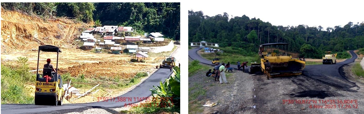
Gambar 3.9 Peningkatan Jalan Menuju Kuburan Kristen Malinau Barat
