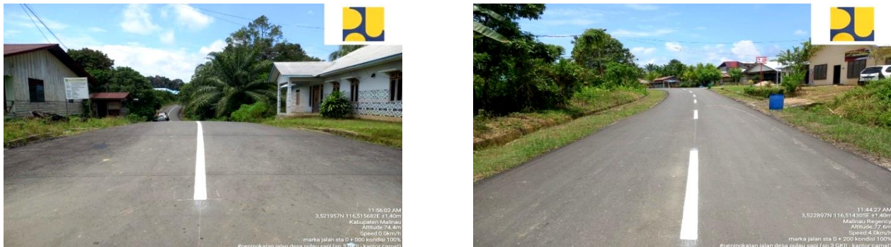
Gambar 3.26 Peningkatan Jalan Desa Pulau Sapi ( Simpang GKII-Simpang Kantor Camat )
