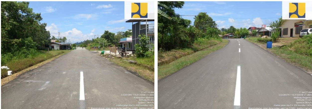
Gambar 3.30 Peningkatan Jalan Desa Setarap - Kantor Camat Masehi
