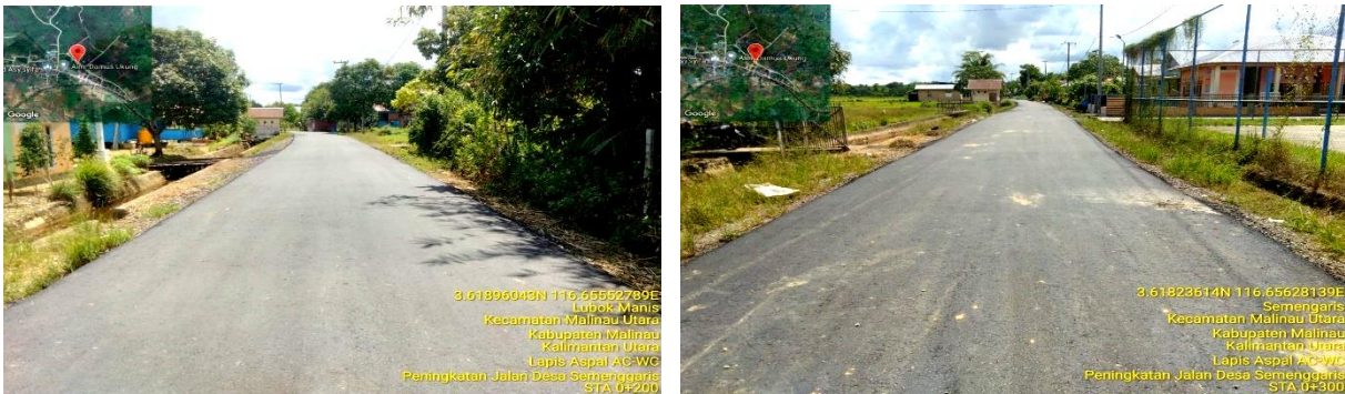
Gambar 3.11 Peningkatan Jalan Desa Semenggaris
