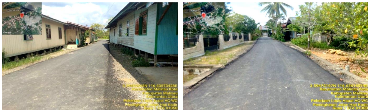
Gambar 3.22 Peningkatan Jalan Lingkungan II RT 18 (Jl. H.KADIR)
