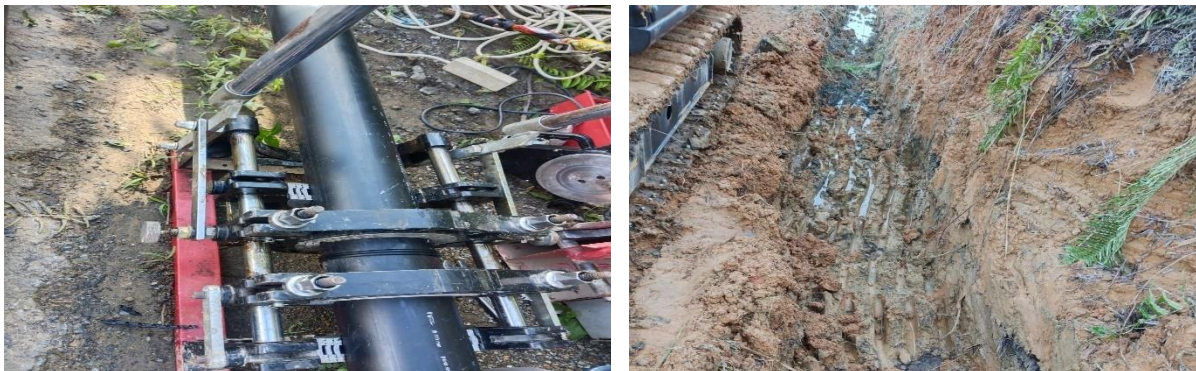
Gambar 3.46 Pembangunan Jaringan Air Bersih di Pemukiman Sengayan arah Desa Sesua
