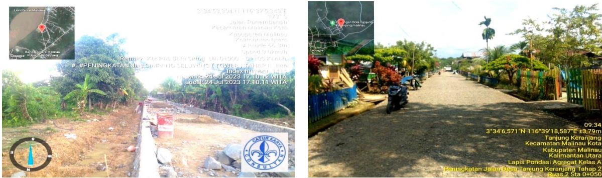
Gambar 3.12 Peningkatan Jalan Dalam Desa Tanjung Kranjang
