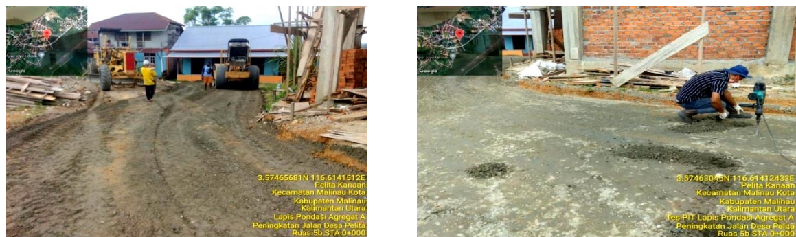
Gambar 3.21 Peningkatan Jalan Desa Pelita Kanaan
