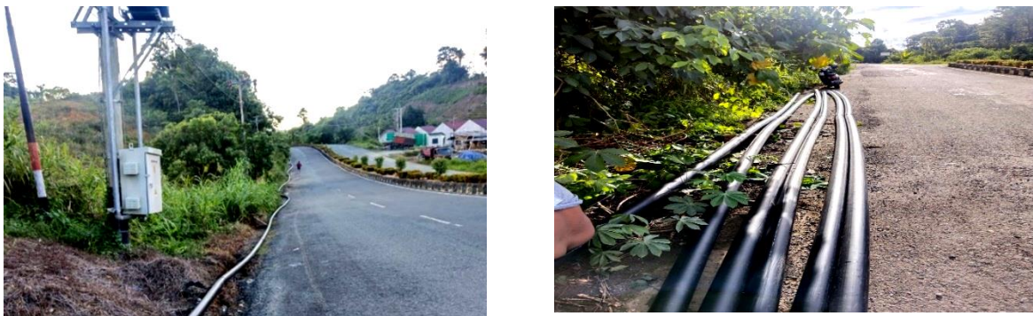
Gambar 3.50 Pembangunan Jaringan Air Bersih Jl. Poros Tanjung Lapang, RT. 2
