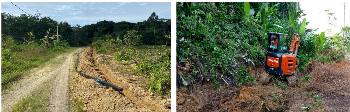
Gambar 3.54 Pemasangan Jaringan PDAM di Jalan Swadaya Lidung Keminci
