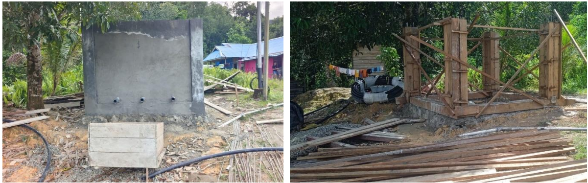
Gambar 3.56 Pembangunan Air Bersih (SPAM) Dusun Rajuk RT. 4 Desa Paking
