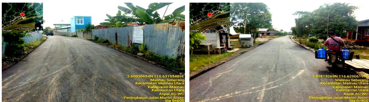
Gambar 3.15 Peningkatan Jalan Mantri Anom Malinau Utara Tahap II
