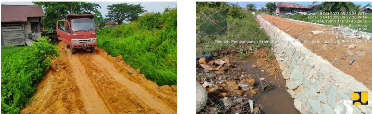
Gambar 3.2 Pembangunan Jalan Simpang Swadaya RT 13 Menuju Jalan Raja (SMP 1 Malinau Kota
