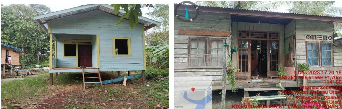
Gambar 3.45 Renovasi Rumah Tidak Layak Huni
