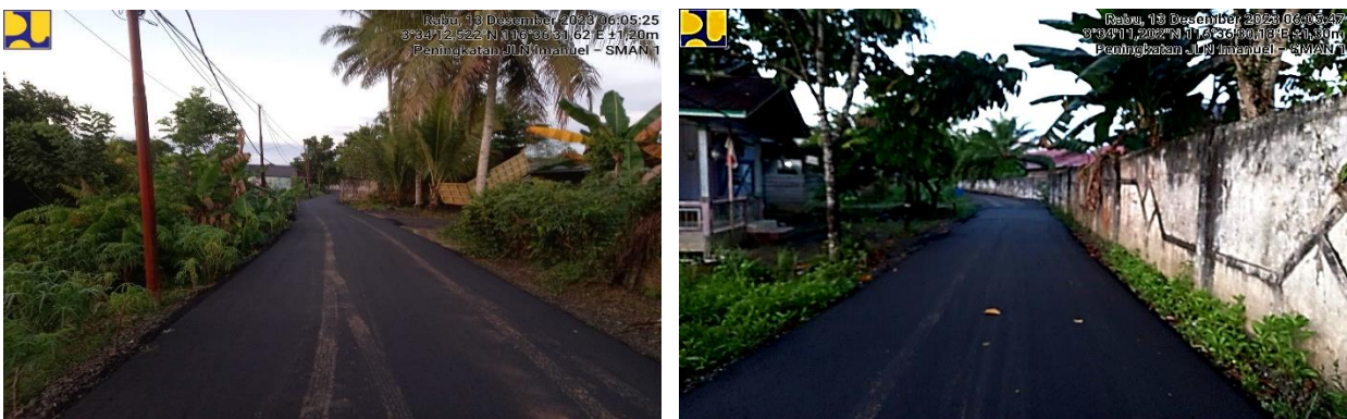
Gambar 3.32 Peningkatan Jalan Samping SMA 1 Malinau - Jl Imanuel
