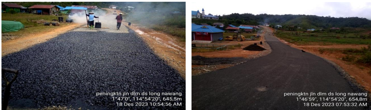
Gambar 3.5 Peningkatan Jalan Dalam Desa Long Nawang
