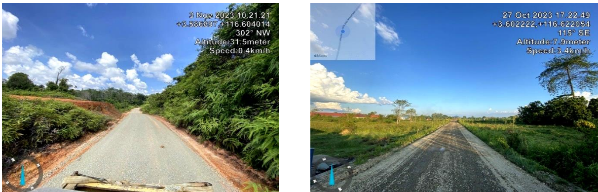
Gambar 3.1 Pembangunan Jalan Pasar Malinau Seberang
