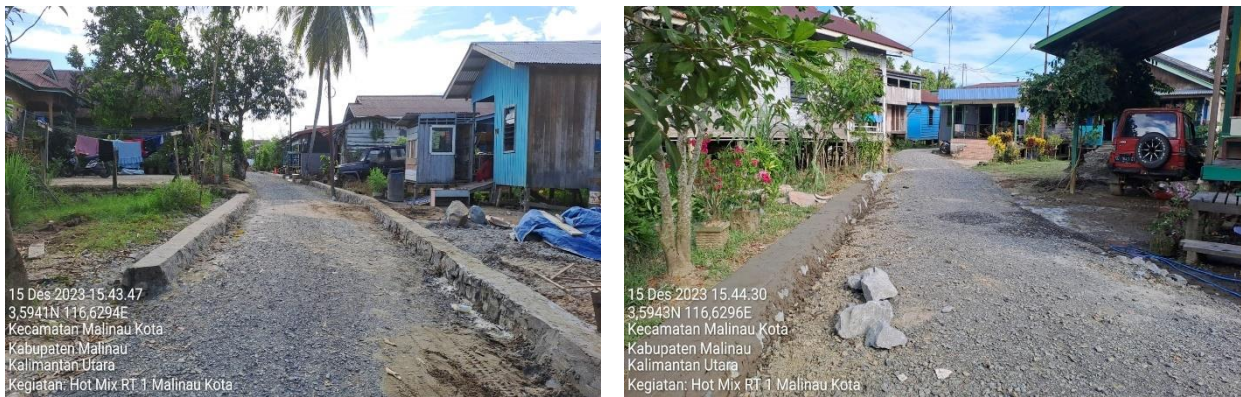
Gambar 3.31 Peningkatan Jalan RT.1 Menuju RT.17 Malinau Kota
