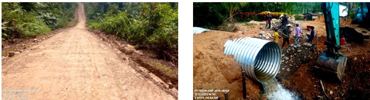
Gambar 3.14 Peningkatan Jalan Dalam Desa Long Kemuat
