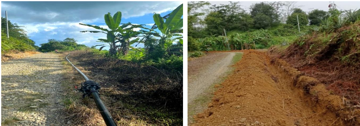
Gambar 3.49 Pembangunan jaringan air minum desa sesua RT 3
