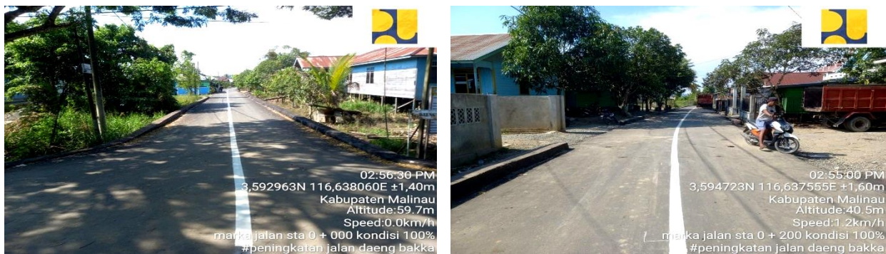
Gambar 3.19 Peningkatan Jalan Daeng Baka RT.18 Malinau Kota
