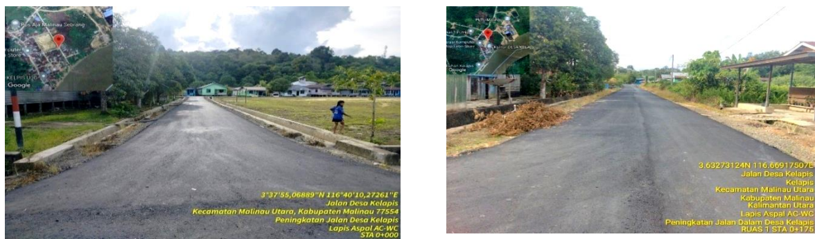
Gambar 3.20 Peningkatan Jalan Desa Kelapis
